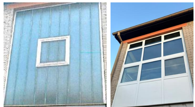
Bild links: vorher - alte Fenster, Bild rechts: nachher – neue Fenster (Fotos: Stefanie Kimmel)
