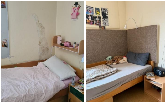
Links: Tapete beschädigt = Situation vor der Renovierung (Foto: JHZ); Rechts: Blick in ein Kinderzimmer nach der Renovierung (JHZ)
